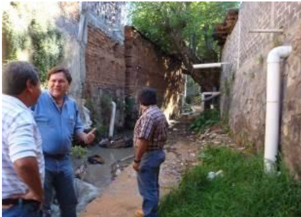
Fotografía 2.- Descargas de aguas residuales domiciliarias al cauce del río.
